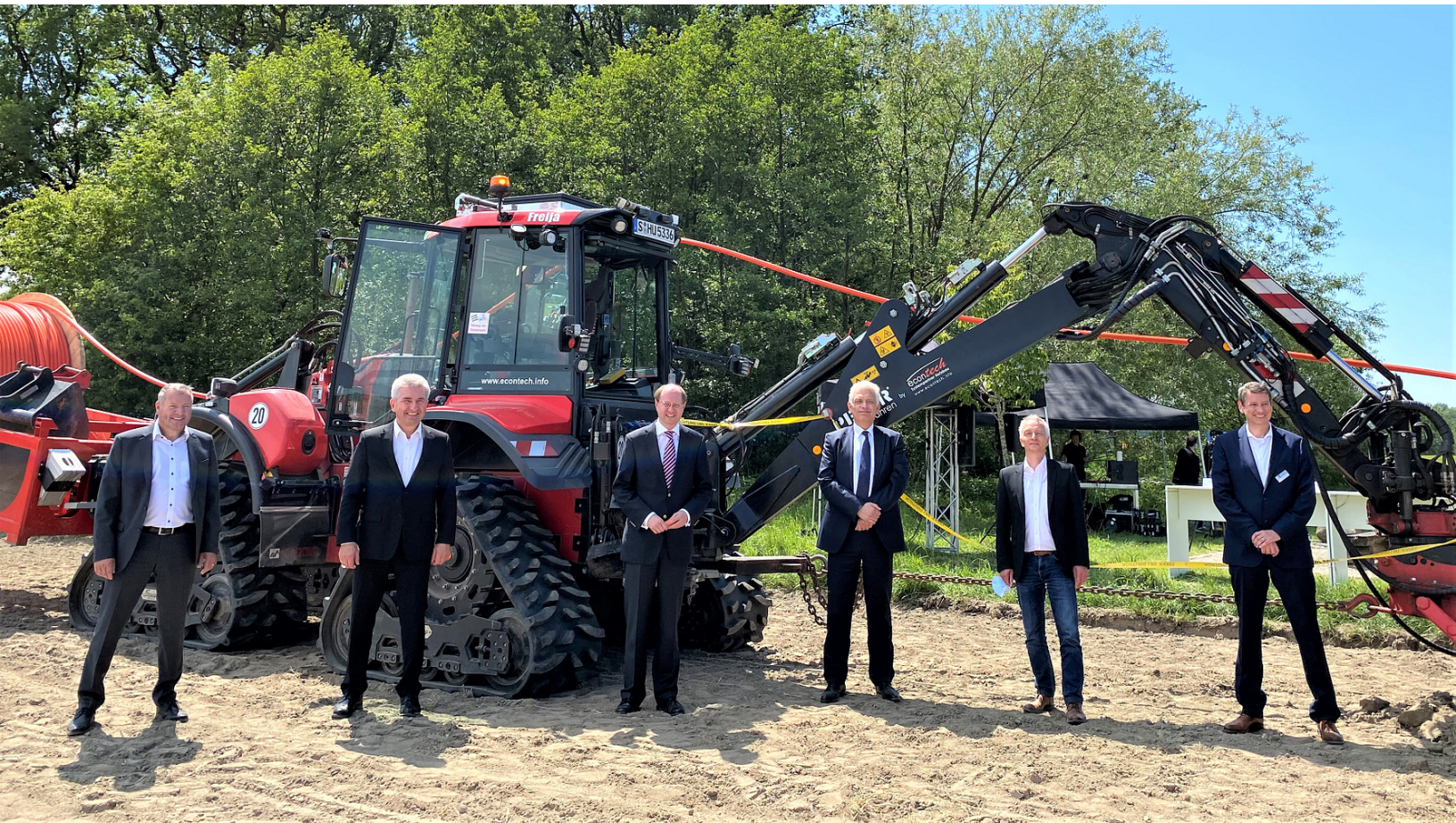
Flächendeckendes Glasfasernetz für Kreis Warendorf: U.a. NRW-Digitalminister Prof. Dr. A. Pinkwart (2. v.l.), Landrat Dr. Olaf Gericke (3. v.l.) und Dr. Stephan Zimmermann, Geschäftsführer von Deutsche Glasfaser vor dem "Glasfaserpflug". (DG)
