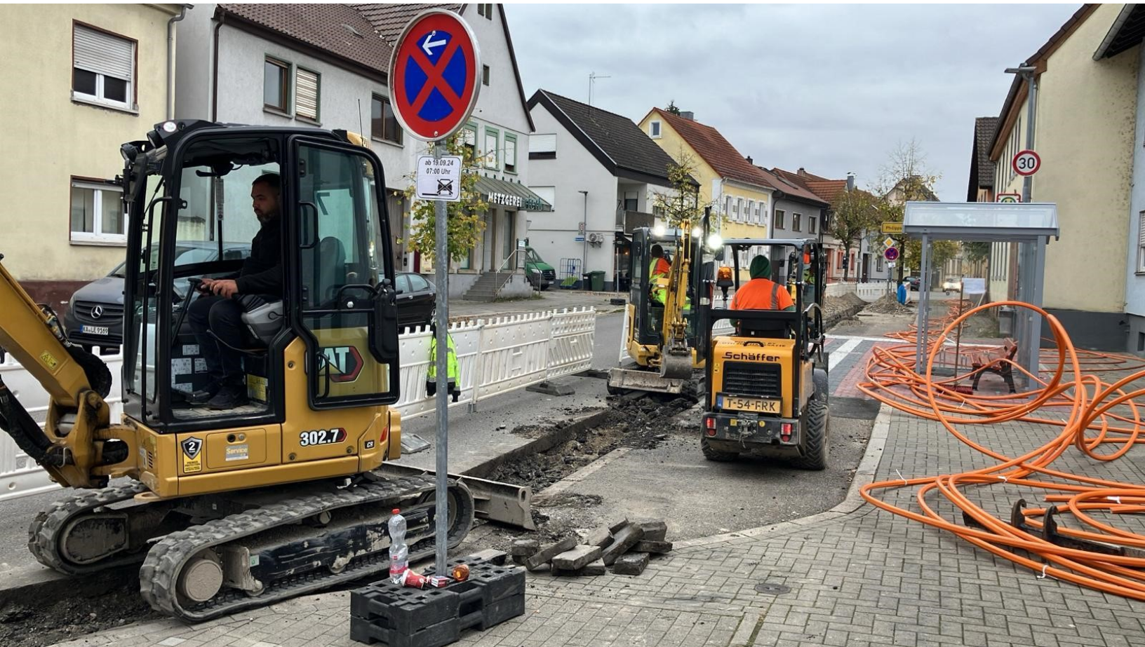
Tiefbauarbeiten in Dettenheim für den Glasfaserausbau.
