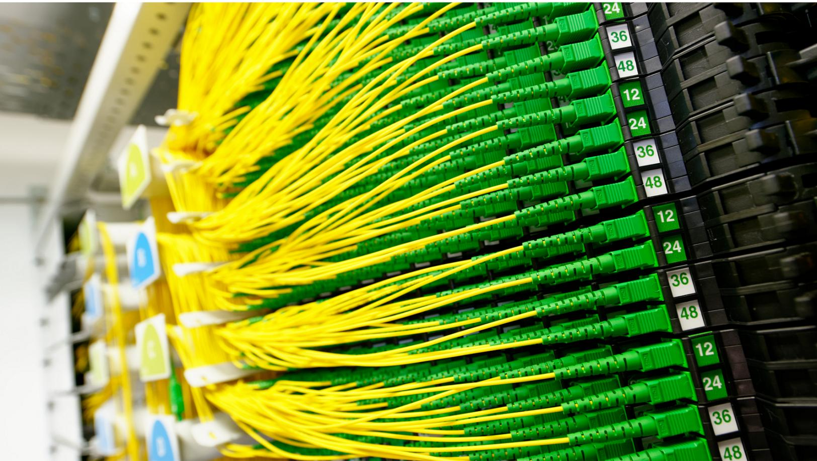
Im Inneren des Glasfaserhauptverteilers: Die "Adern" aus reiner Glasfaser innerhalb des 'POP's (Point of Presence) von Deutsche Glasfaser. (DG)
