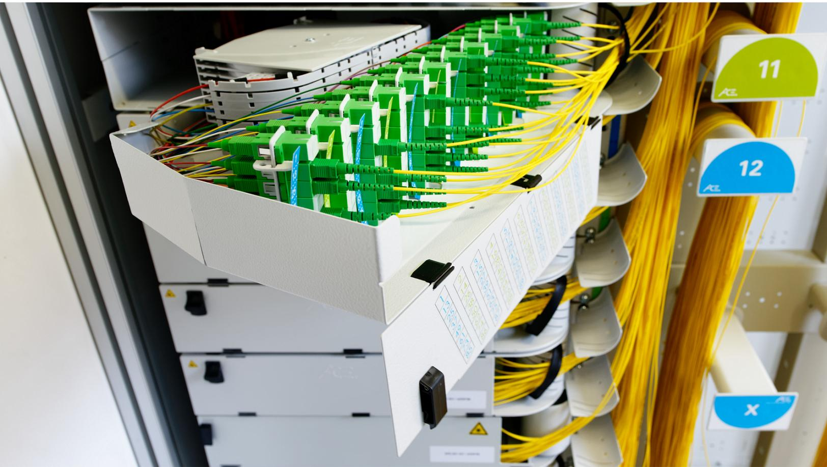
Im Inneren des Glasfaserhauptverteilers: Die "Adern" aus reiner Glasfaser innerhalb des 'POP's (Point of Presence) von Deutsche Glasfaser.
