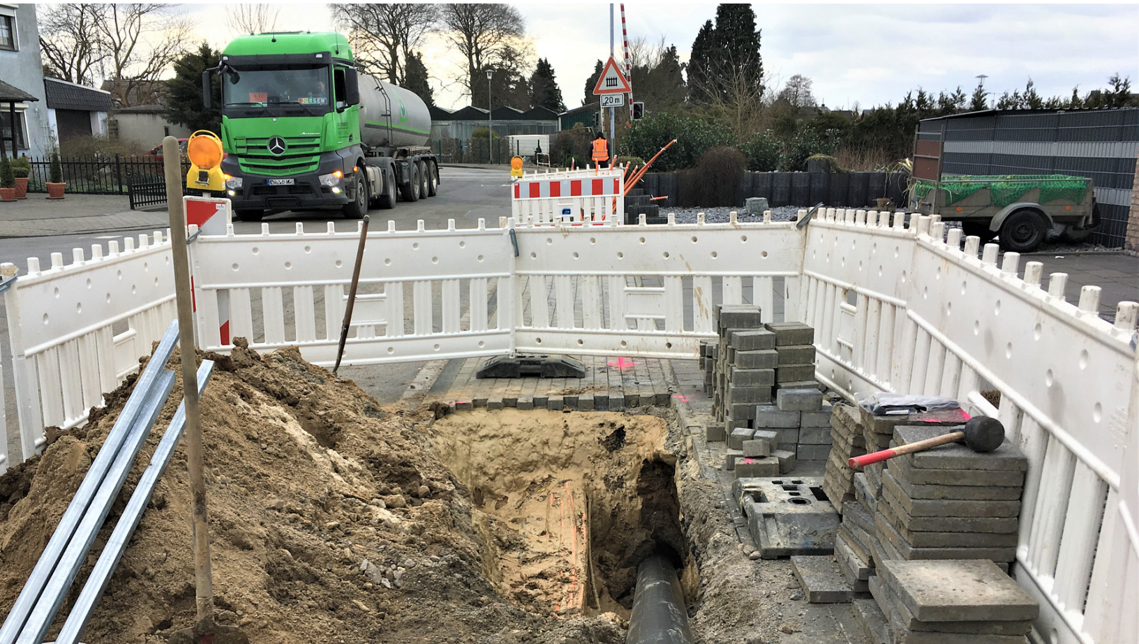
Arbeiten zur Bahnquerung in Nieukerk: Bahnfrei für Glasfaserausbau in Kerken - Foto/Rechte: DG
