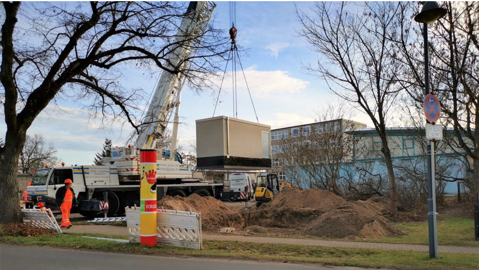
Aufstellung eines Hauptverteilers in Saarmund
