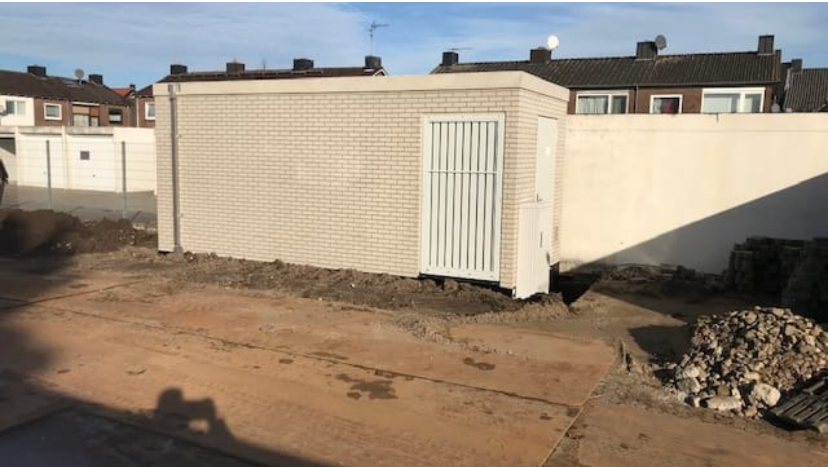
Glasfaserhauptverteiler in Elten an der Wasserstraße.
