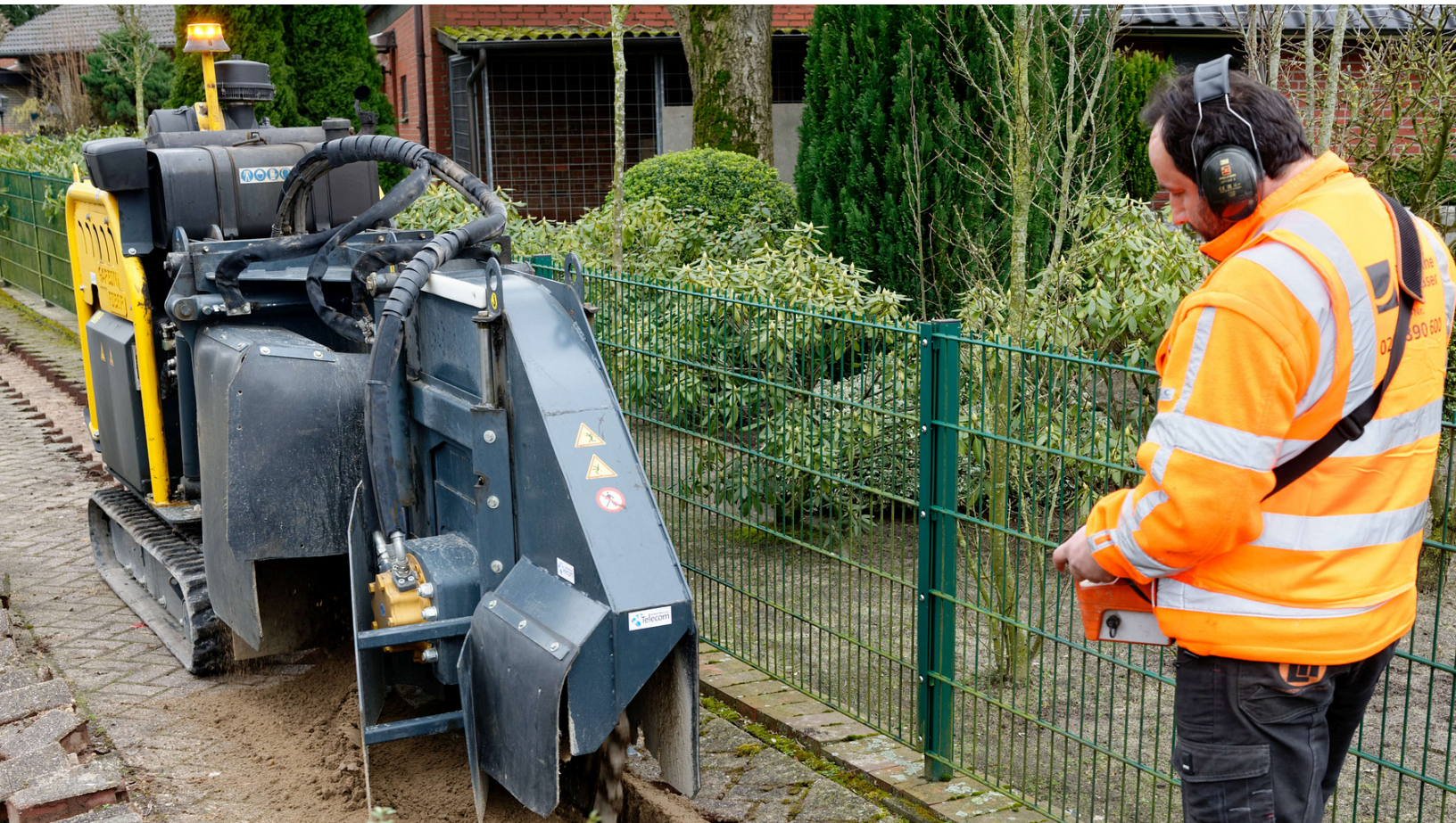
Glasfaserausbau mit dem Fräsverfahren
